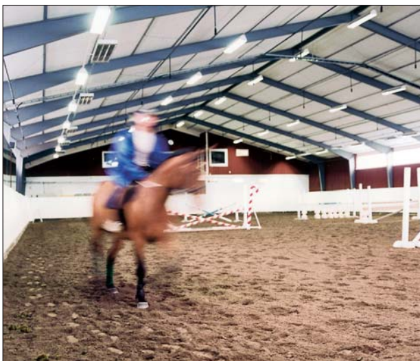
Человек, находящийся в зоне действия приборов, поглощает лучистую энергию и ощущает себя комфортно даже при невысоких температурах. Это свойство дает возможность снижать среднюю температуру в помещении без потери комфортности. Напомним, что снижение температуры на 1 градус - это снижение энергопотребления примерно на 5%!
